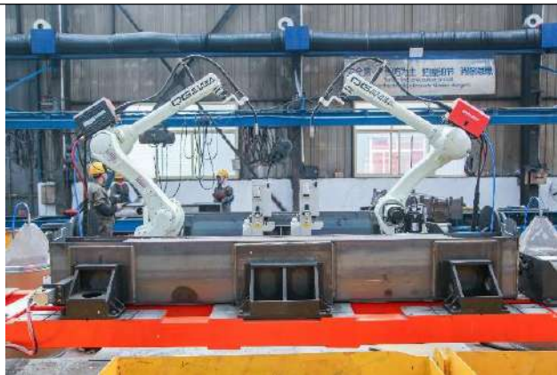
单梁主梁内缝焊接机器人
