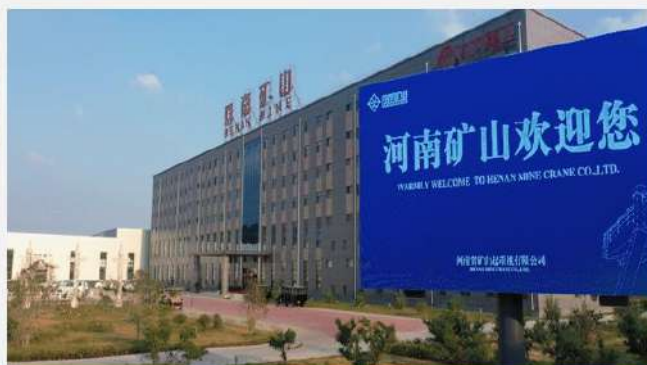
河南矿山产业园
