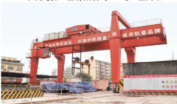
中隧集团重庆轨道交通六号线U型地铁翻渣门吊
